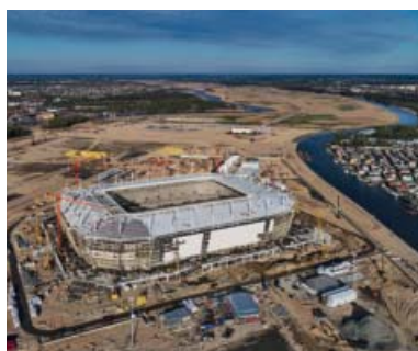
Das neue Kaliningrader Stadion im Bau (Mai 2017) uf der Pregel-Insel Lomse.
